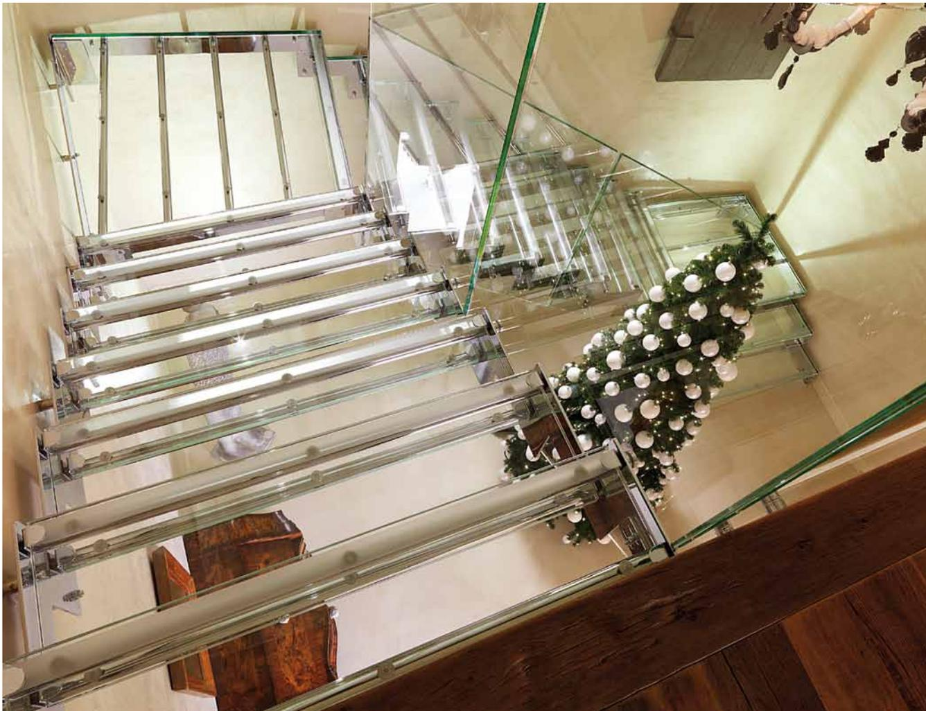
*Nel cuore della dimora, una scenografica ed elegante scala in cristallo e acciaio cromato lucido, realizzata a misura tramite avanzata rappresentazione grafica con disegni a 3D. Parapetto in cristallo extrachiaro stratificato temperato fissato alla struttura mediante perni autoportanti. I gradini trasparenti si snodano lungo tre lati, permettendo in ogni punto la spettacolare visione dell'area sottostante (Prospektiv s.r.l., Telgate – Bg).
